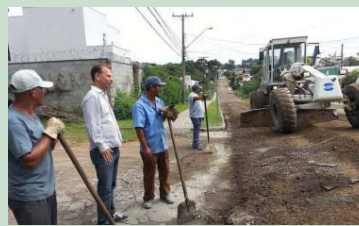
Acompanhando as obras de revitalização da Rua José Nicco
